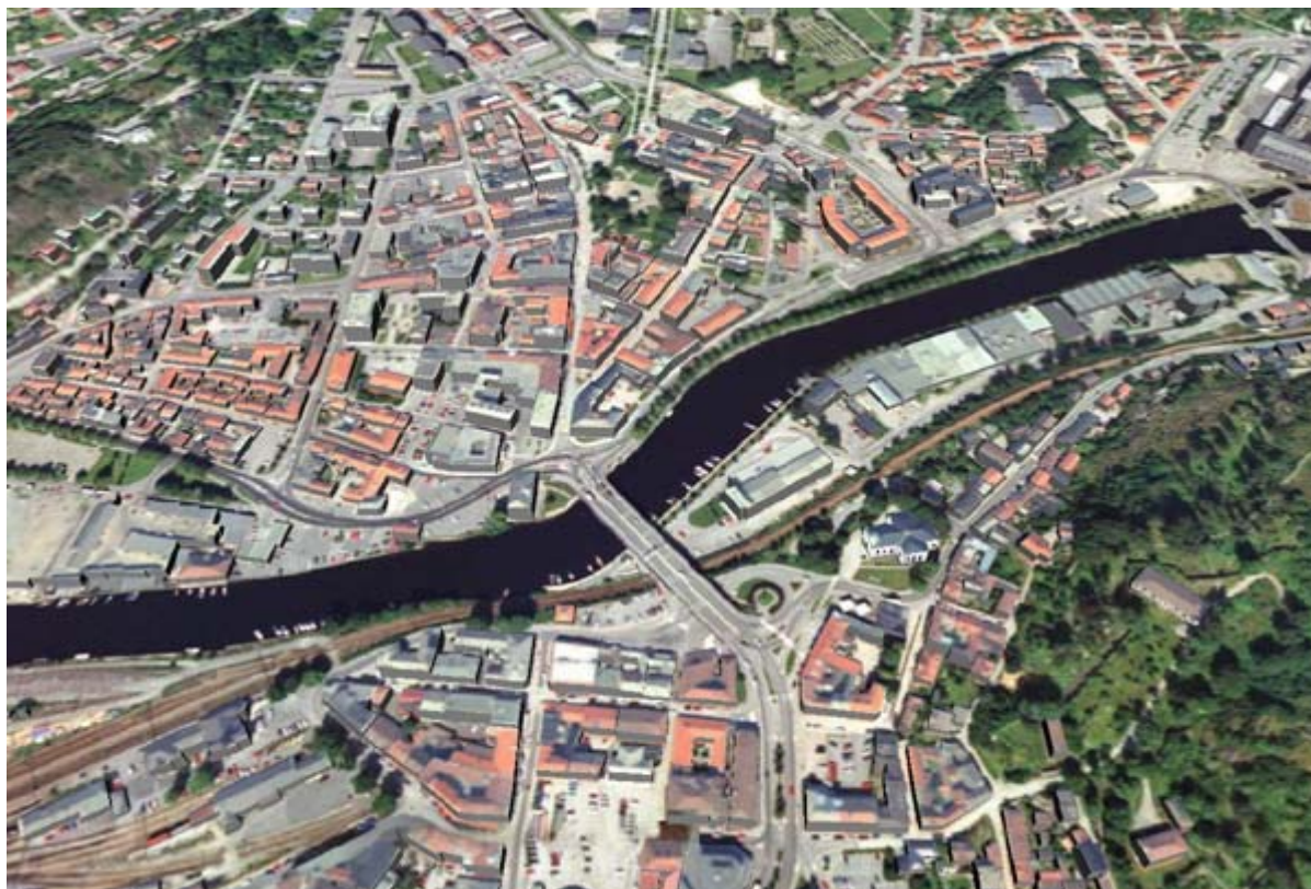
Figur 6.10. Oversiktsbilde over Halden Sentrum
